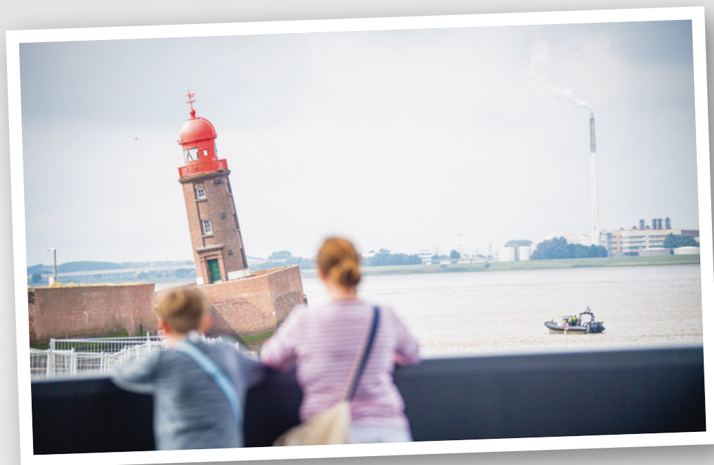
◀ Das „Pressefoto des Jahres“ – abgelichtet vom Fotografen Arnd Hartmann – zeigt den im August 2022 abgesackten Molenturm in Bremerhaven in neuer Schiefelage
